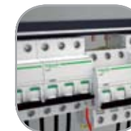
Демонтаж на устройство при поставен захранващ гребен.
